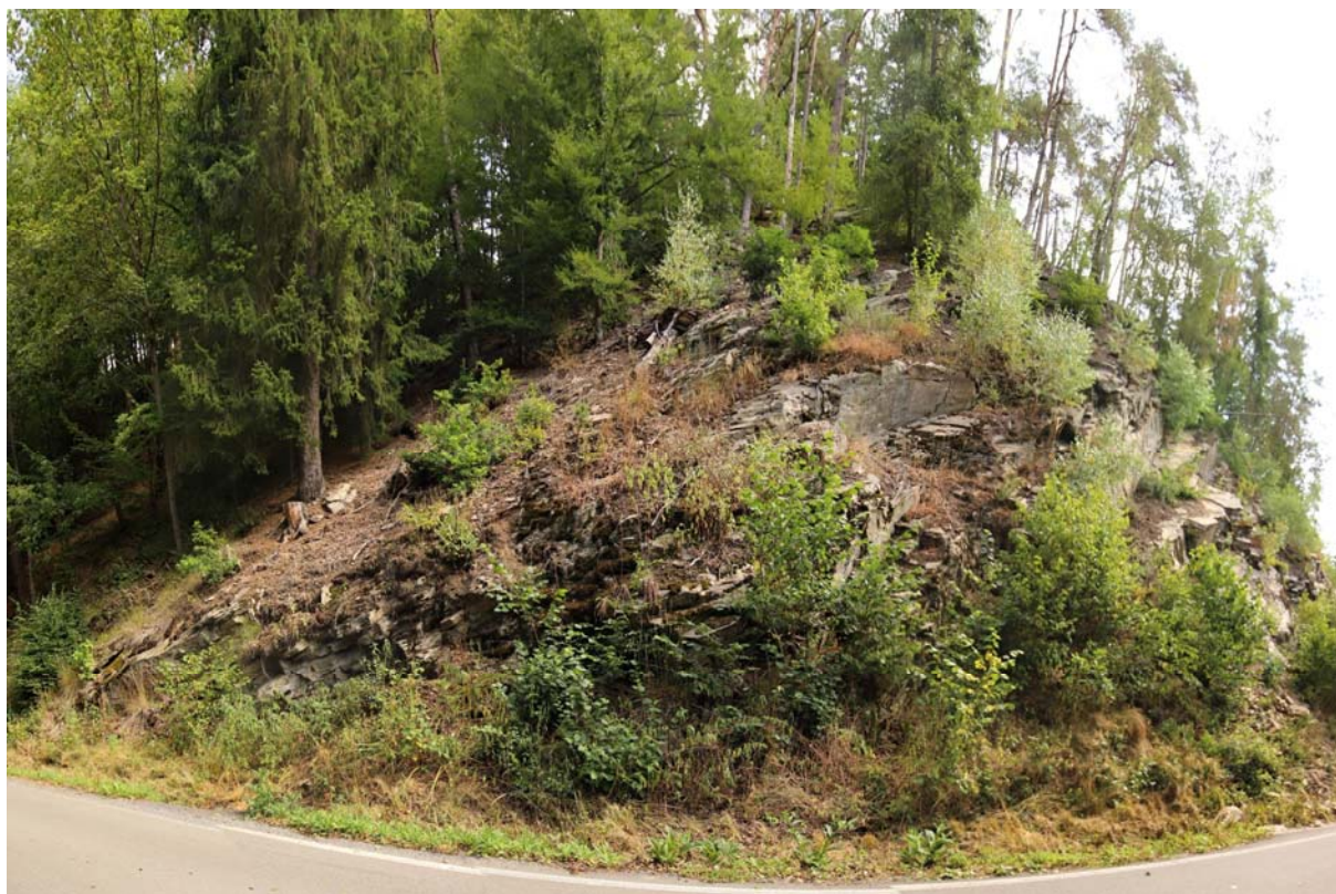
Obrázek 19: panoramatický pohled na skalní masiv v km 3,640 – 3,660, dokumentace stavu zvětrání a hustoty porostu vegetací, stav zaplnění paty svahu napadávkami, často je i zaplněn prostor odvodnění
