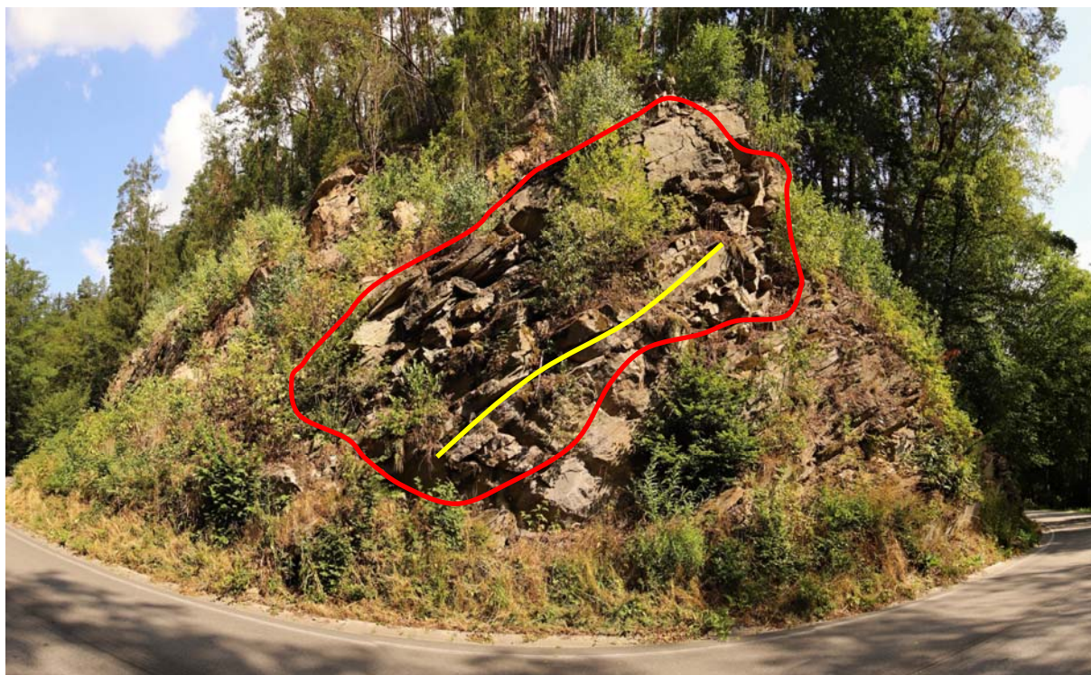
Obrázek 16: pohled na skalní svah nízké lokace do 5 m výšky nad komunikací, vyznačena oblast nutná k očištění od volných částí masivu – s návaznou instalací lanových panelů, pata svahu zaplněna napadávkami u podélného odvodnění komunikace, km 3,570 – 3,590, vyznačen hlavní sklon ploch odlučnosti - foliace
