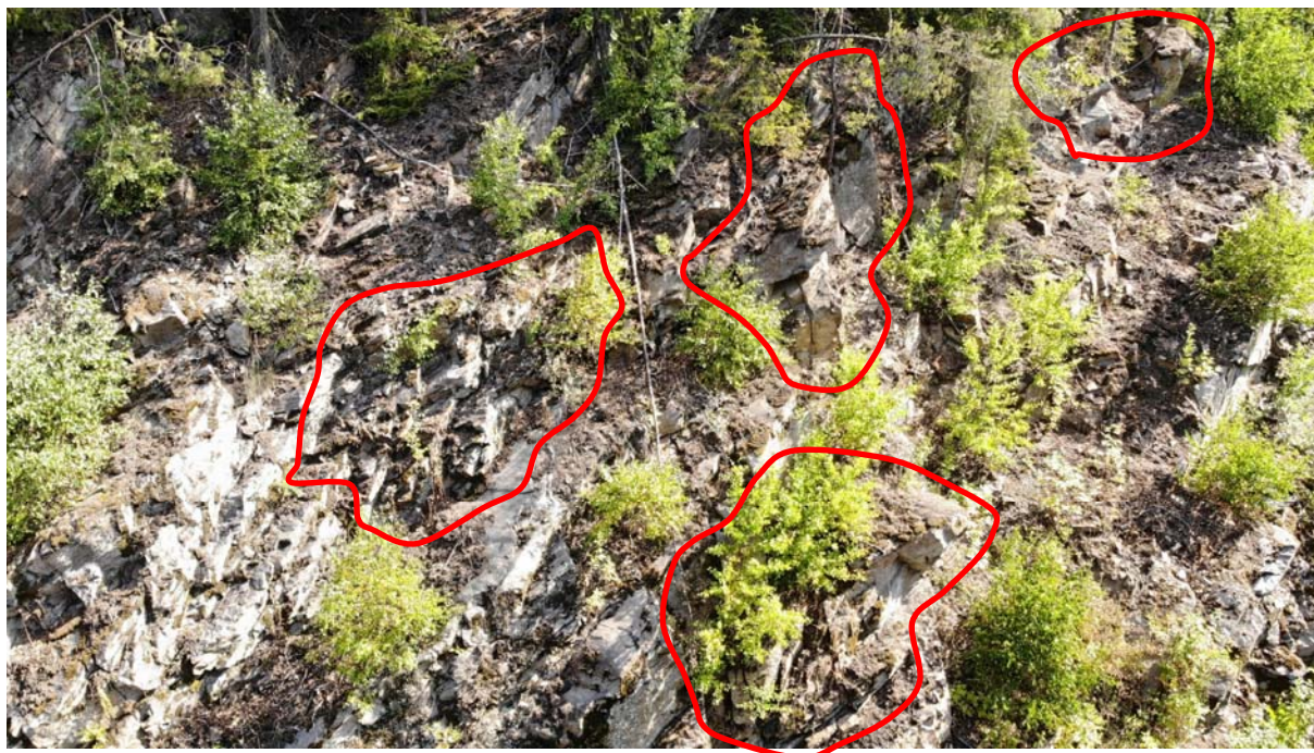
Obrázek 5: horní partie skalního svahu v km 3,575 - 3,580 s vyznačením vysoce rizikových rozvolněných blokových struktur masivu, výška ve svahu nad 5 m
