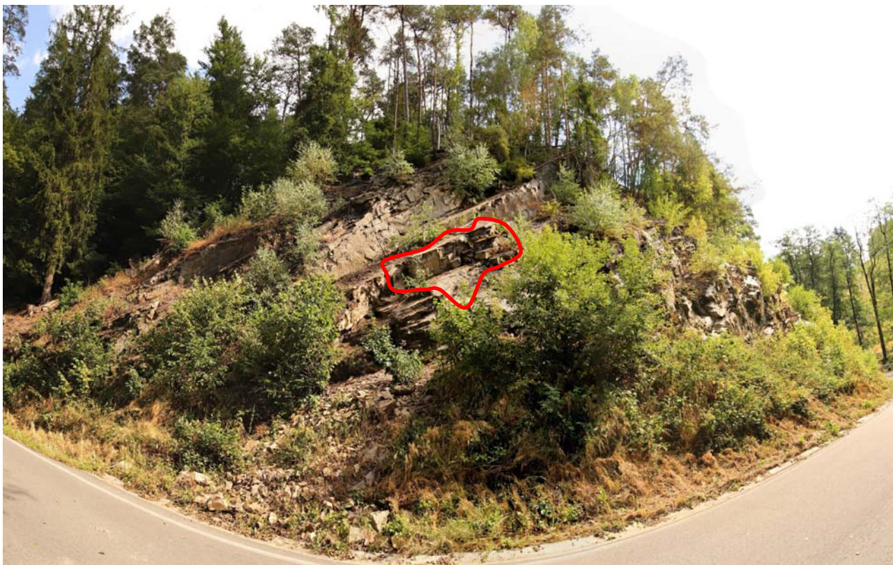
Obrázek 4: místo odlučné plochy předchozího řízení skalního svahu, které částečně ohrozilo provoz na silnici III/38710, km 3,635 – 3,640, objem cca 1,35 m 3
