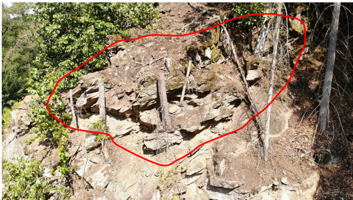
Obrázek 11: labilní bloková struktura v km 3,565 - 3,570, vysoká lokace 6 - 10 m, zcela rozvolněno, odloučeno od mateřského masivu, pukliny 30 - 40 mm, lokálně až 55 mm, vyplněno hlinitým pískem, znatelný častý erozní a mrazový účinek vody, objem 4,5 m 3
