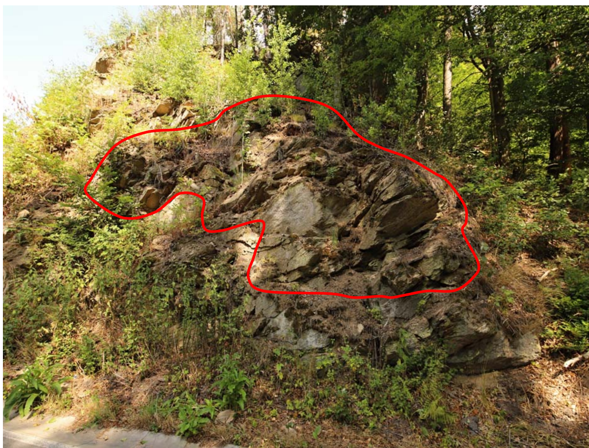
Obrázek 14: pohled na skalní svah nízké lokace do 5 m výšky nad komunikací, vyznačena oblast nutná k očištění od volných částí masivu – s návaznou instalací lanových panelů, pata svahu zaplněna napadávkami u podélného odvodnění komunikace, km 3,565 – 3,570
