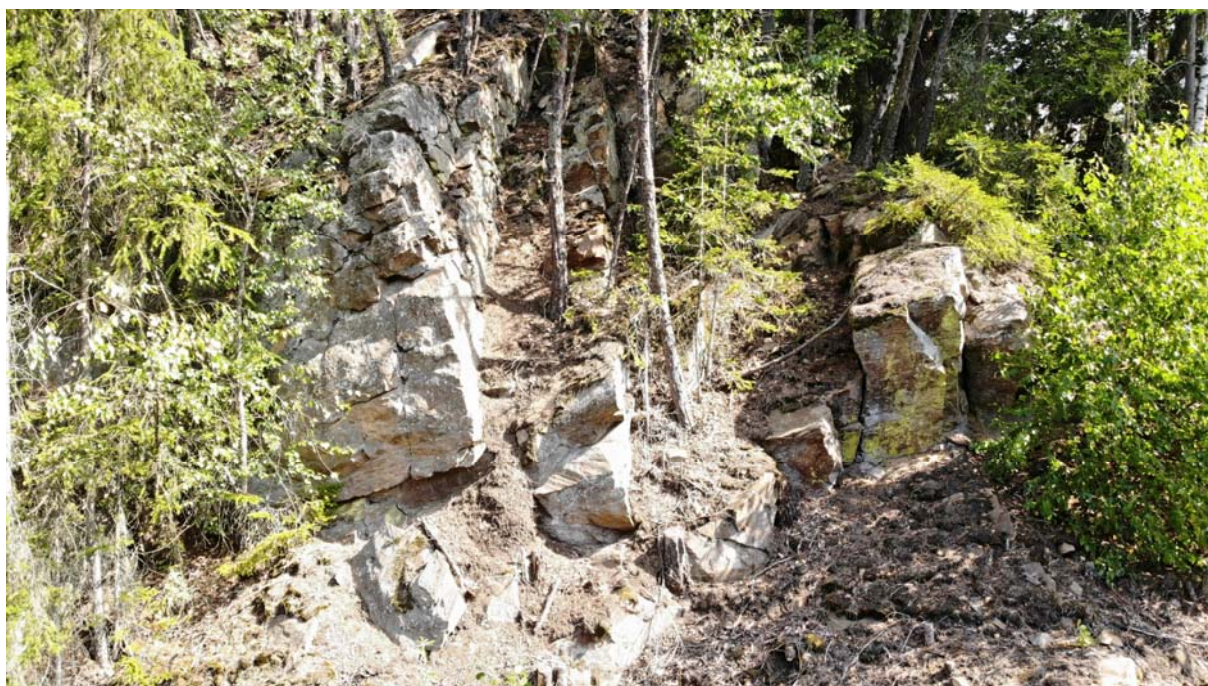
Obrázek 10: příklad narušených bloků masivu ve vysoké lokaci nad komunikací (výška více jak 15 m), bloky jsou vrazně zatěžovány stromy a jejich kořenovým systémem, rozevření puklin více jak 15 mm
