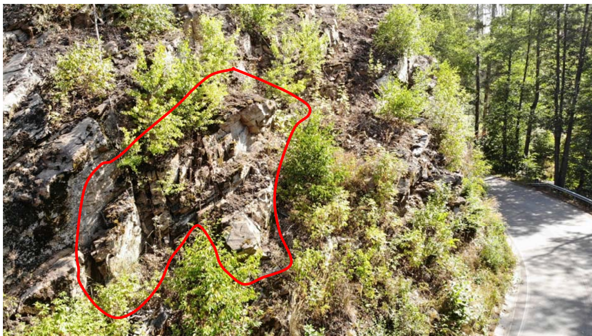
Obrázek 7: lokalizace rizikové struktury v km 3,585 ve výšce cca 4,5 - 5,8 m nad komunikací, objem struktury cca 3,5 m 3
