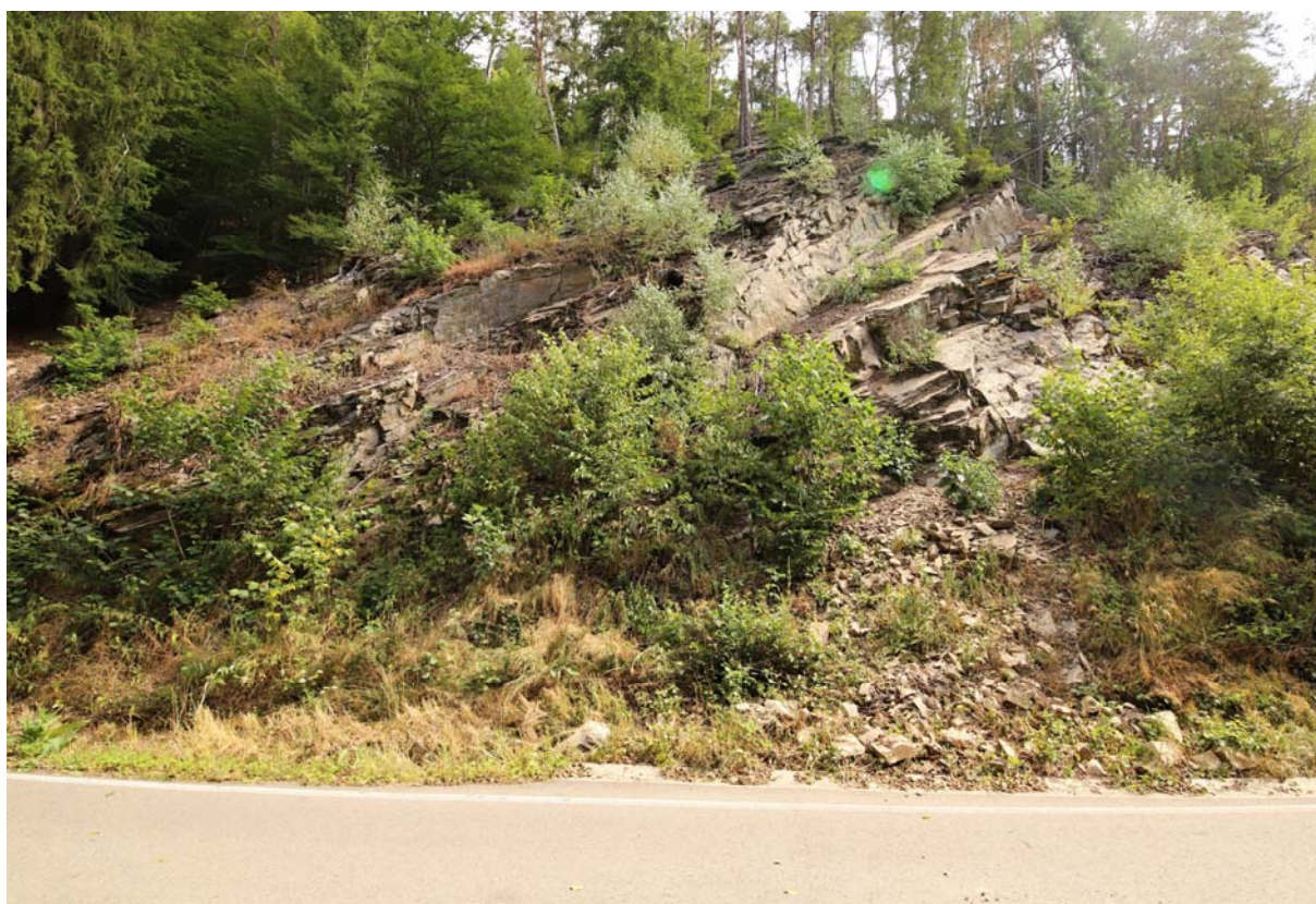
Obrázek 18: panoramatický pohled na skalní masiv v km 3,610 – 3,640, dokumentace stavu zvětrání a hustoty porostu vegetací, místo aktivace řícení, stav zaplnění paty svahu napadávkami, často je i zaplněn prostor odvodnění
