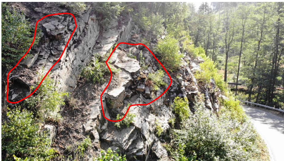
Obrázek 9: pohled na labilní struktury masivu v km 3,620 - 3,630, výška nad komunikací cca 5,5 m, zobrazena popisovaná stupňovitá struktura stavby svahu dle tektonických poruch a ploch foliace s úklonem ze svahu
